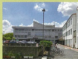
倉敷市立美術館 (写真正面。右は市立中央図書館。)
